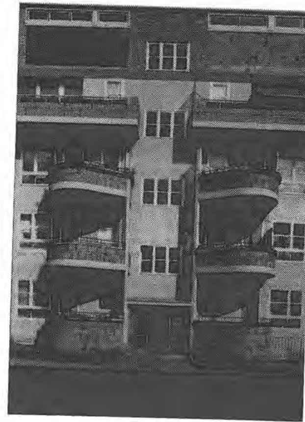
Architect Hugo Häring Siemensstadt
